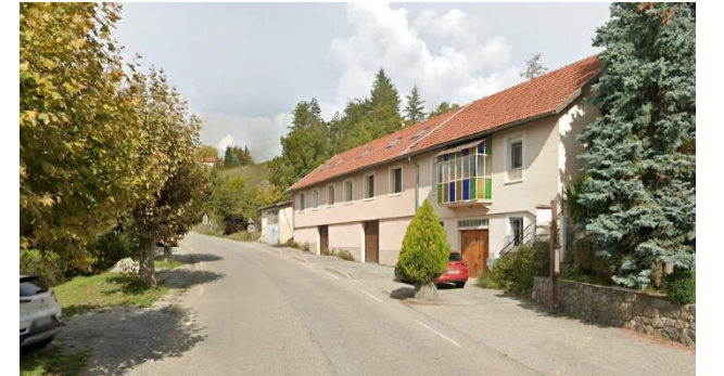
8. constructions existantes en pied de pente, groupées ou mitoyennes en bordure de RD 446
